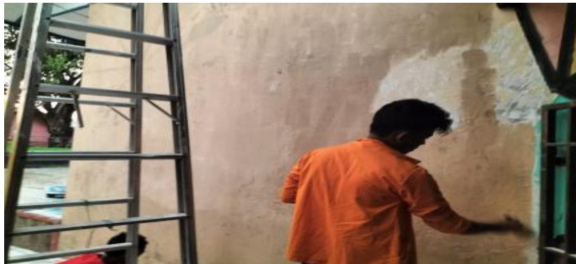
Gambar 2. Pengecatan dasar
