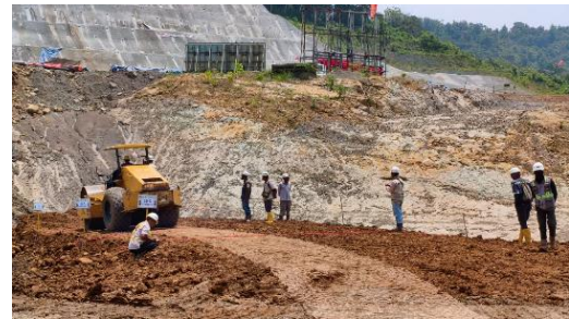
Gambar 1. Pekerjaan Timbunan Main Dam
