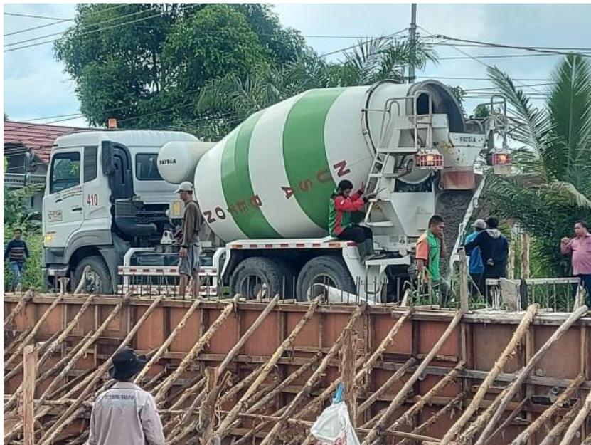
**Gambar 10.** Pekerjaan Pengecoran Menggunakan Concrete Truck Mixer
