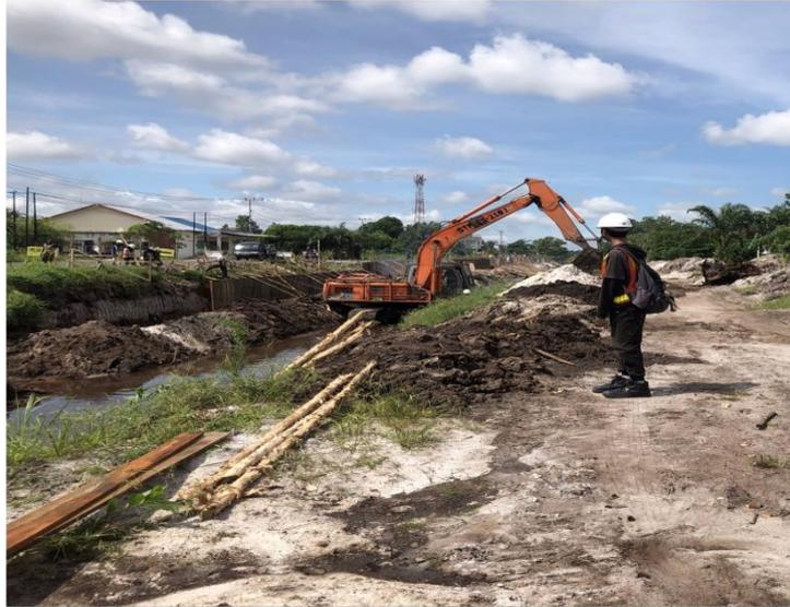
**Gambar 9.** Penggalian Saluran dengan Alat Excavator Standard
