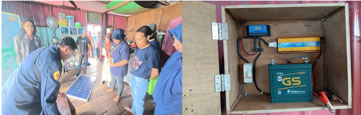
Gambar 2. Instalasi sistem penyimpanan ikan betenaga surya
